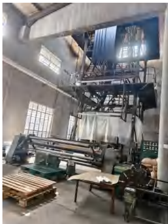
废气收集系统
